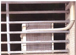
外機管線以修飾管保護管線
