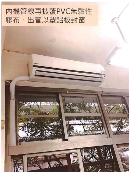
外機管線以修飾管保護管線
