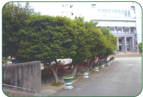
改建前為老舊斜坡及階梯，危機重重
